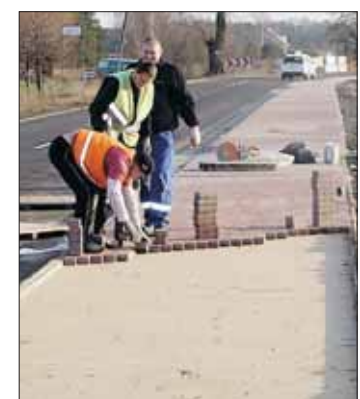
Ciąg pieszo-rowerowy w Olszewnicy Starej
