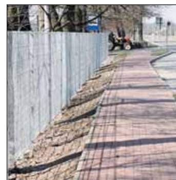
Ogrodzenie Szkół w Skrzyszewie
