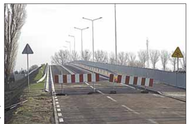
Wiadukt w Skrzeszewie
