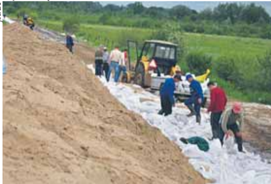
... a jednak ich ciężar umacniał nasiąkniętą podstawę wału
