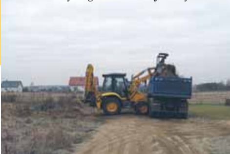
Budowa nowej drogi w Olszewnicy Starej
