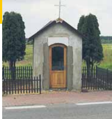
Kaplica w Olszewnicy w trakcie...
