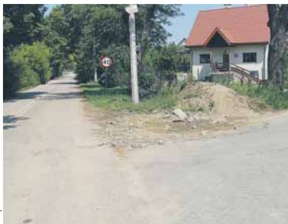
Ulica Poprzeczna po naprawie
