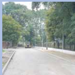
Prace na ul. Spokojnej
