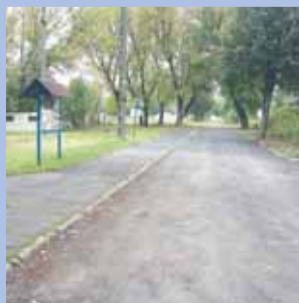
Wyremontowany dojazd do osiedla Silikaty w Michałowie-Reginowie
