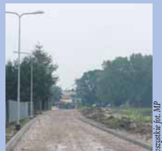
Prace na ul. Świętojańskiej
