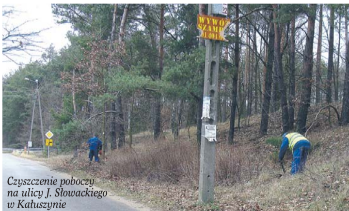
Usuwanie piasku z asfaltu na ulicy 600-lecia w Wieliszewie
