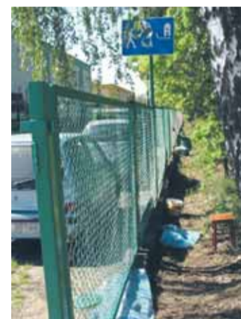
Malowanie ogrodzenia osiedla 600-lecia stać z unikalnych walorów otaczającej przyrody.
