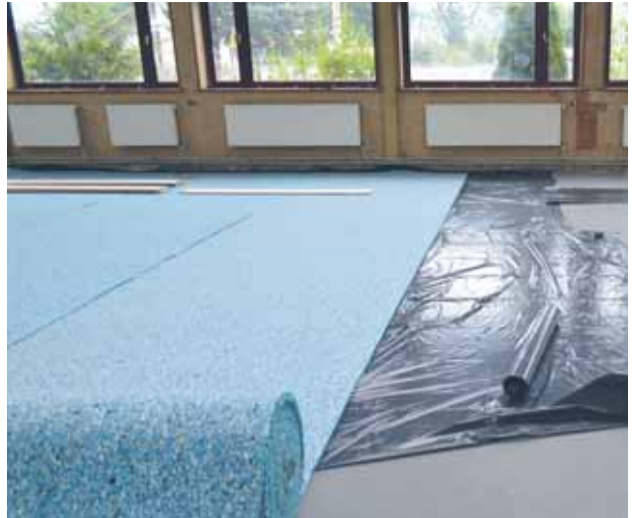
Hala Sportowa w Wieliszewie. Rozpoczęcie prac na Hali Sportowej pod koniec lipca – zerwanie nawierzchni
