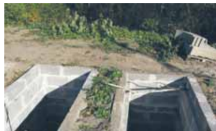
Możliwe jest podniesienie terenu poprzez zasypanie jedynie przestrzeni pomiędzy komorami grobowymi.
