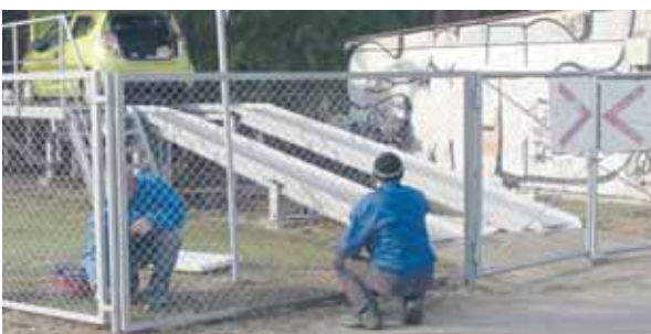
Malowanie stanowiska do obsługi samochodów na osiedlu 600-lecia
